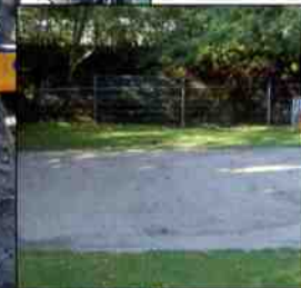
Bleibt beim Betreten der Fläche lediglich ein leichter Schuhabdruck zurück, ist der Untergrund fest genug – der Poolaufbau kann beginnen
