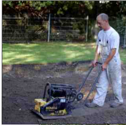
Erst wird eine Schicht Schotter aufgebracht und mit einem Rüttler verfestigt
