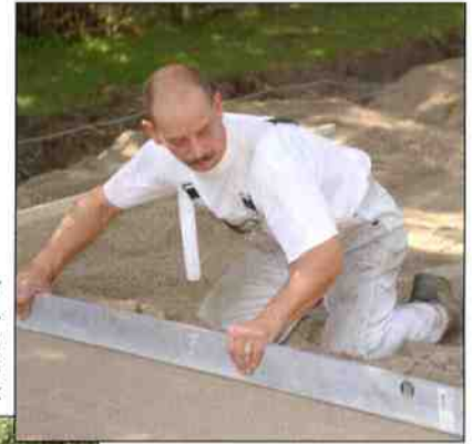
Über den Schotter kommt eine Sandschicht. Ist diese gleichmäßig waagrecht verteilt, wird sie ebenfalls verdichtet
