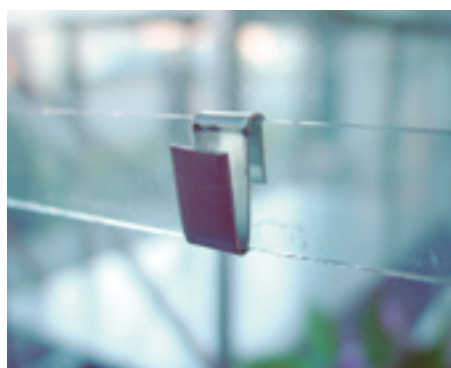
11. Die überlappenden Glasscheiben werden mit Glashaltern befestigt.
