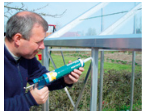
9. Bei bedarf können Sie mit Silikon arbeiten.
