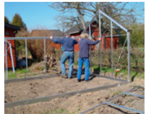
6. Die Profile werden auf dem Fundament mit J-Beschlägen befestigt.
