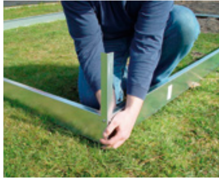
2. Das Fundament wird zusammengescreibt.
