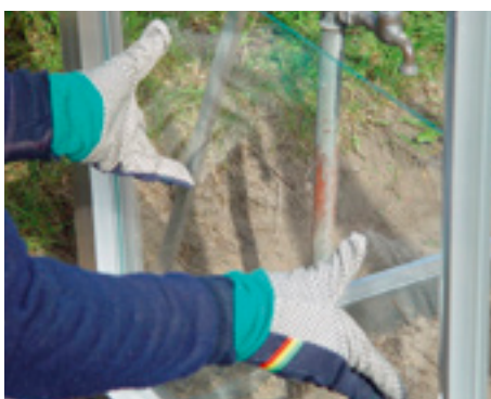
10. Das Glas wird auf dem nassen Silikon gedrückt.
