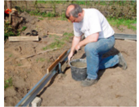
3. Die Löcher werden ca. 80 cm tief gegraben und zementiert. Absichern, dass das Fundament im Lot ist.
