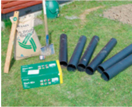
1. Gießmaterial für das Fundament.
